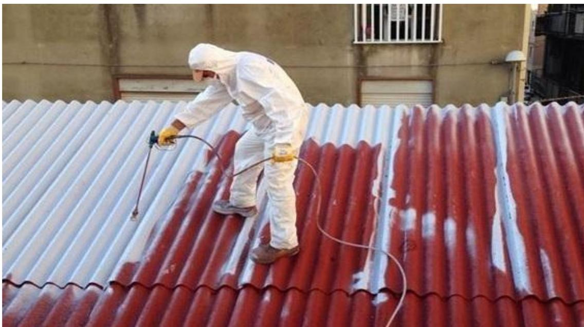
**Figura 1 incapsulamento e rimozione di pannelli di cemento amianto**
