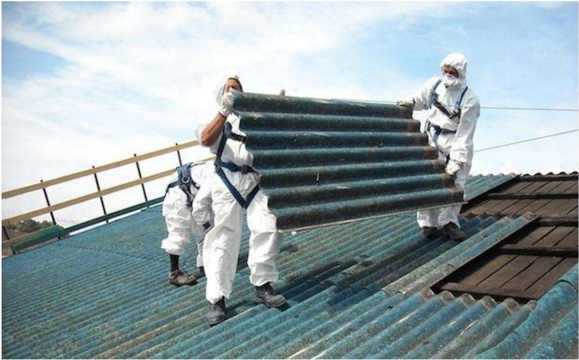
**Figura 2: rimozione dell'amianto**
